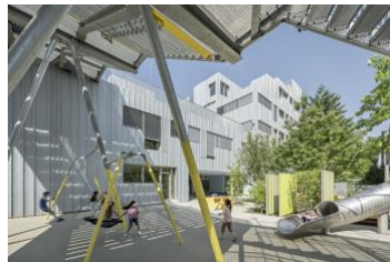
Schule Längenfeldgasse , Wien, 2020.
