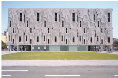
Fassade, Parkhaus Skopje , Nordmazedonien, 2013.
