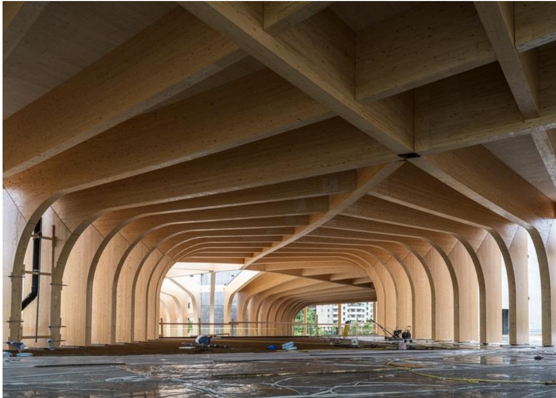
World of Volvo Baustelle, Juni 2022 Photo: Rasmus Hjortshøj – COAST
