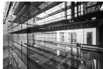
Museum Reinhard Ernst im Aufbau construction © K. Helbig/F. Marburger
