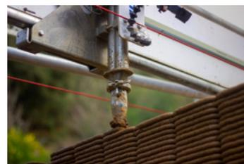
3D-Druck eines Erd-Prototypen\_Detail. © IAAC
